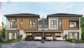
Grande PLENO พลับพลา - วิภาวดี 3 THB 50 million 8 units
